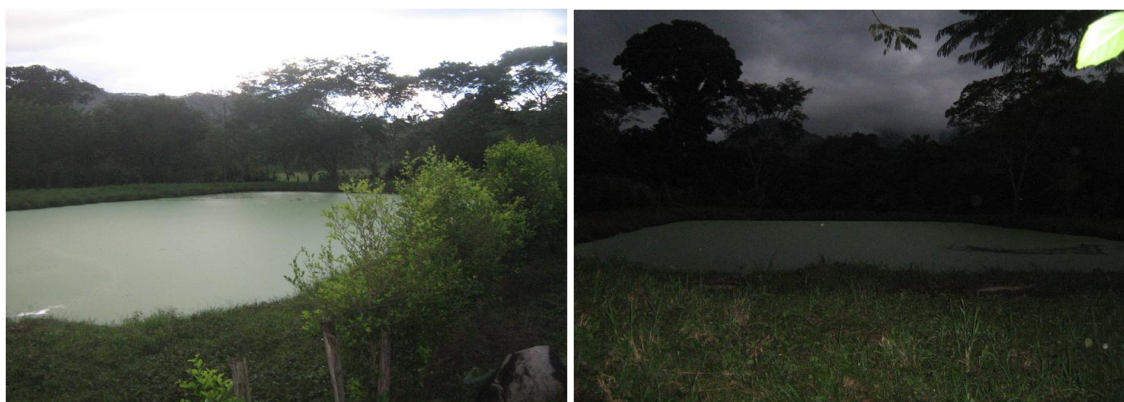
Figura 70. Instalaciones del sistema de tratamiento de aguas residuales en Chimila.
