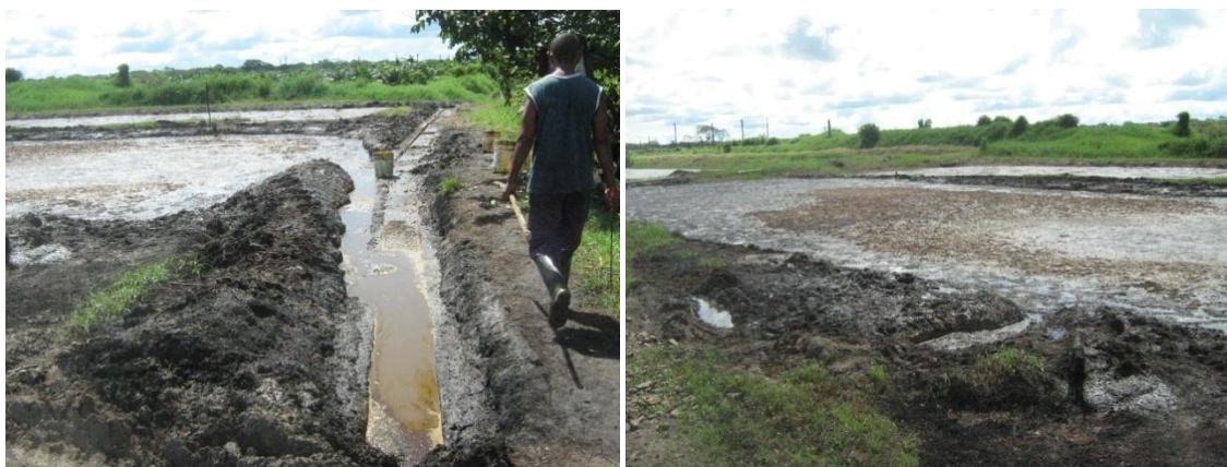
Figura 34. Instalaciones para el tratamiento de aguas residuales en la empresa PALMARIGUANI.
