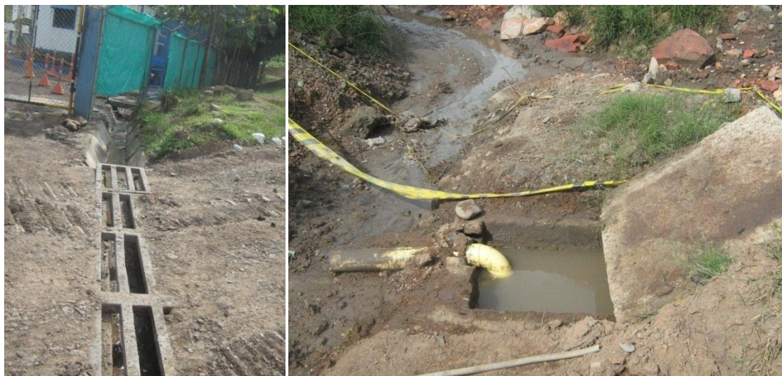
Figura 75. Instalaciones para el tratamiento de aguas residuales en ORICA.
