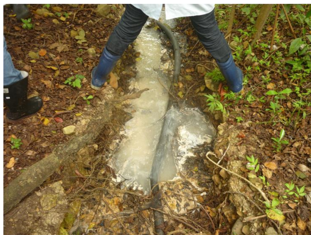
Figura 10. Tubería del vertimiento de FRESKALECHE cortada.
