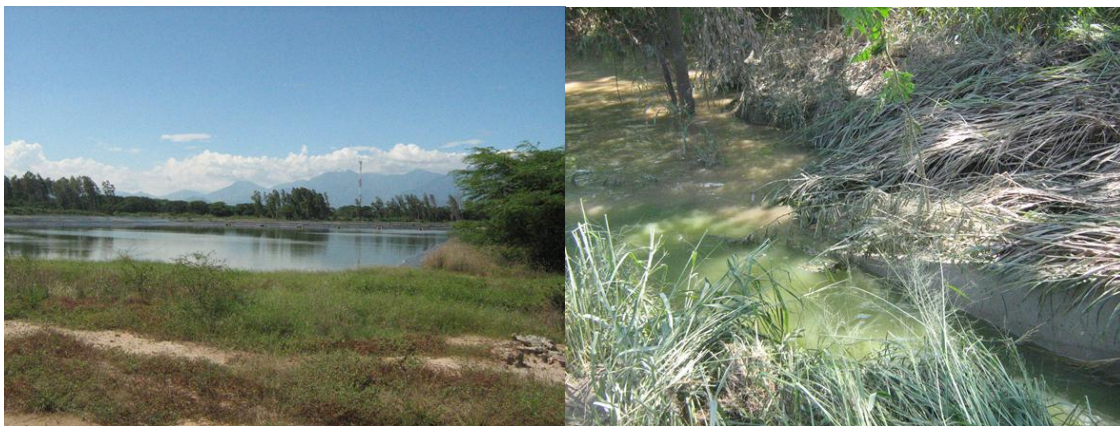
Figura 47. Instalaciones para el tratamiento de aguas residuales en Valledupar (Salguero).
