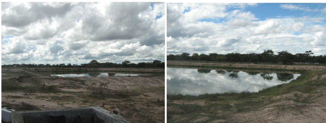
Figura 69. Instalaciones del sistema de tratamiento y sitio del vertimiento de aguas residuales en Cuatro Vientos.
