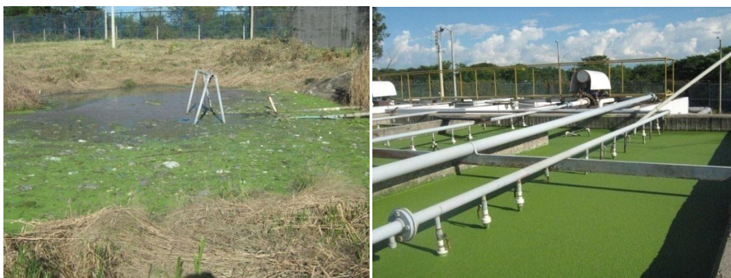
Figura 83. Instalaciones para el tratamiento de aguas residuales en El INPEC.
