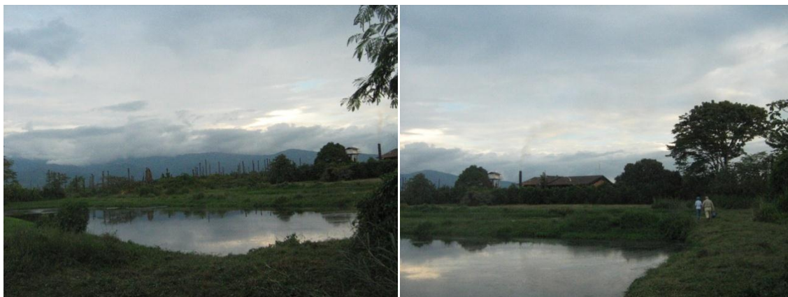
Figura 41. Instalaciones para el tratamiento de aguas residuales en la empresa PALMACARA.
