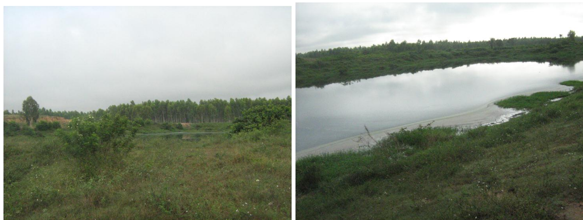
Figura 72. Instalaciones del sistema de tratamiento de aguas residuales en La Loma.
