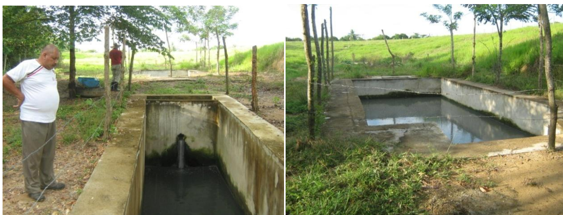
Figura 52. Instalaciones para el tratamiento de aguas residuales en Morrison.
