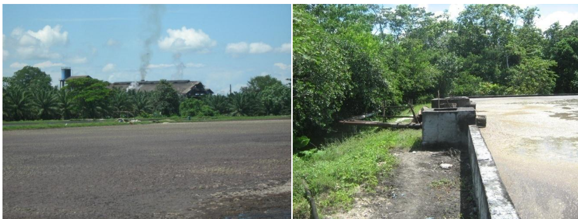
Figura 22. Instalaciones para el tratamiento de aguas residuales en la empresa INDUPALMA.
