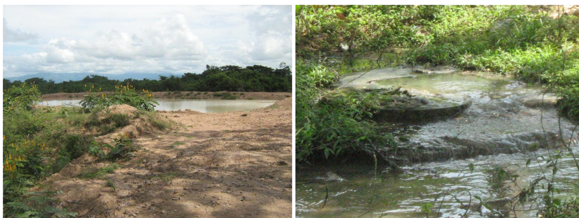
Figura 68. Instalaciones del sistema de tratamiento y sitio del vertimiento de aguas residuales en Antequera.
