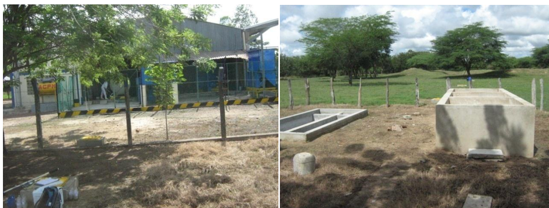
Figura 13. Instalaciones para el tratamiento de aguas residuales en la empresa COOLECHERA.
