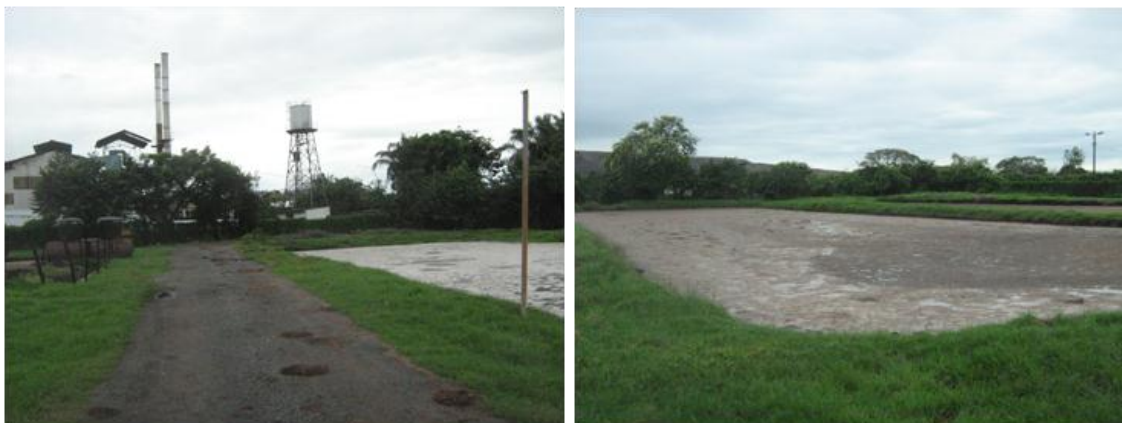
Figura 44. Instalaciones para el tratamiento de aguas residuales en la empresa PALMAGRO.
