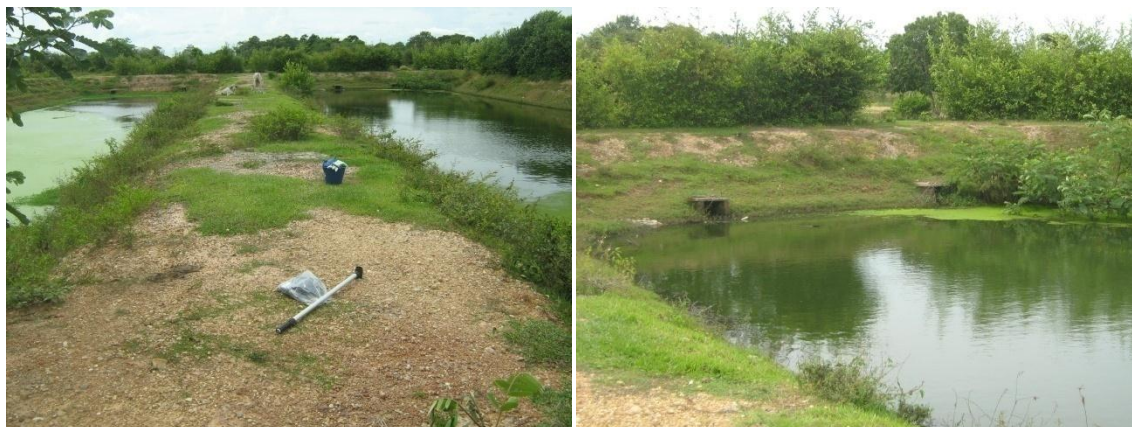
Figura 65. Instalaciones para el tratamiento de aguas residuales en Costilla.
