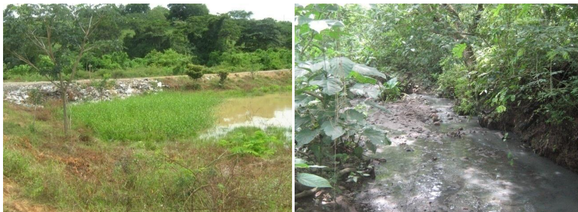
Figura 64. Instalaciones para el tratamiento de aguas residuales en Ayacucho.
