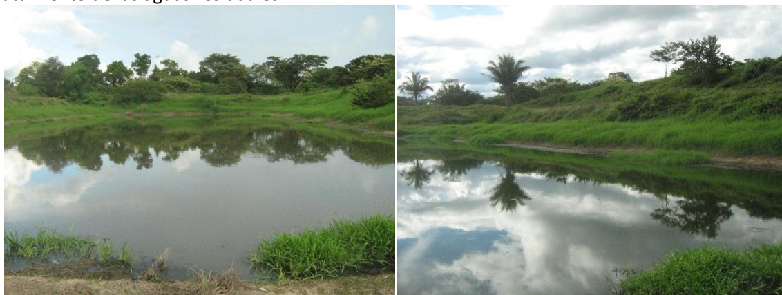
Figura 63. Instalaciones para el tratamiento de aguas residuales en Arjona.
