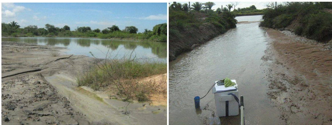
Figura 77. Instalaciones para el tratamiento de aguas residuales en VALE COAL.
