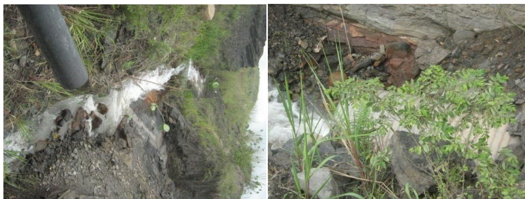
Figura 80. Instalaciones para el tratamiento de aguas residuales en NORCARBON.
