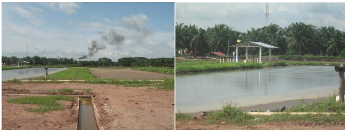
Figura 38. Instalaciones para el tratamiento de aguas residuales en la empresa Oleoflores.
