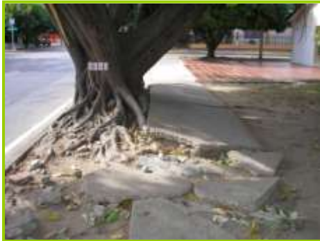
Foto 1. Raíces de con crecimiento excesivo con respecto al lugar de siembra. Típico de especies de la familia moraceae. El caucho es una especie inadecuada para la zona blanda de los andenes y separadores angostos.
