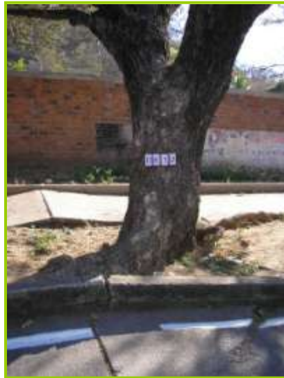
Foto 11. Ondulaciones en la placa de concreto del andén zona dura.
