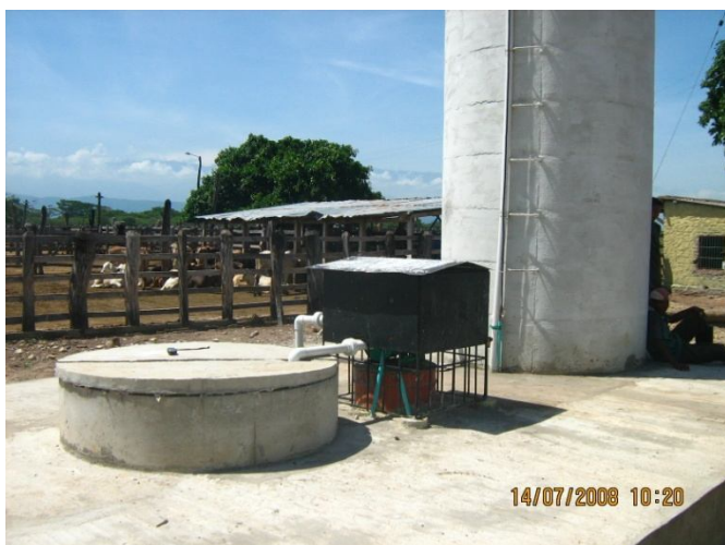
Foto 18. Nótese la protección del aljibe (tapa y alrededores) y de la bomba (caseta metálica)
