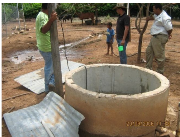
Foto 16. Aljibe sin protección suficiente
