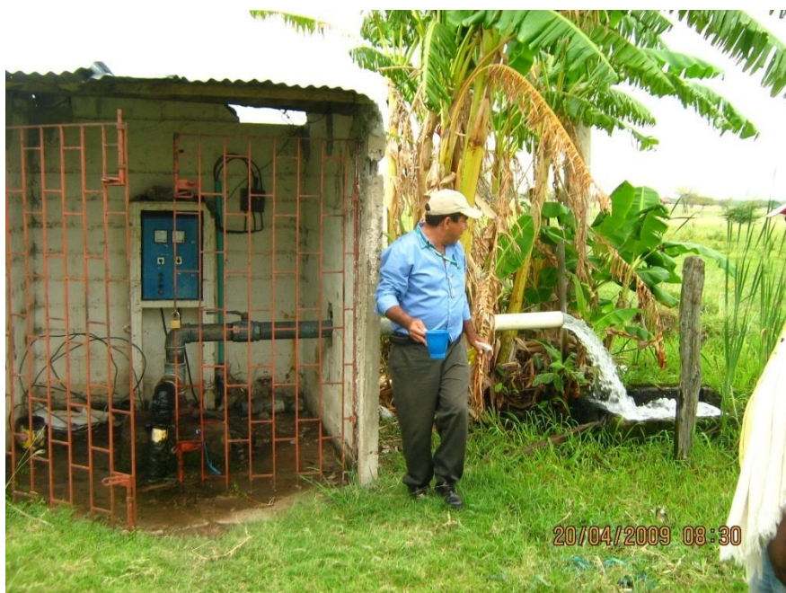
Foto 19. Pozo profundo con protección tanto en la boca como de acceso al mismo (reja de cierre).
