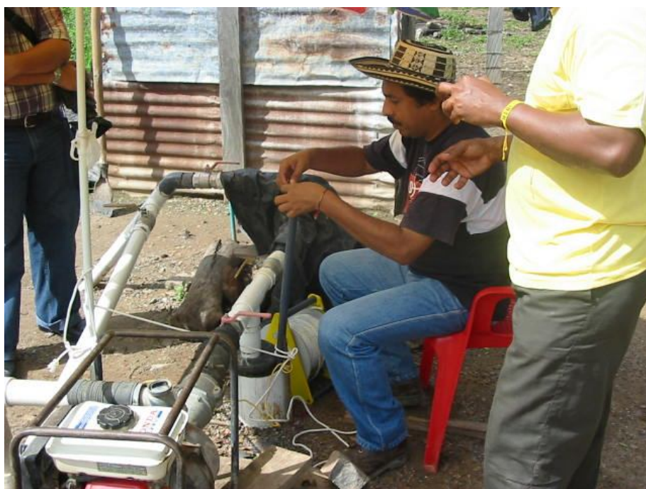
Foto 5. Medición de niveles usando tubería de \frac{3}{4} de pulgada en el interior del pozo
