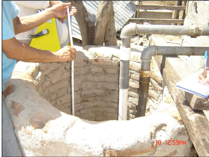
Foto 11. Aljibe con revestimiento en anillos de ladrillo. Uso de la sonda para medición de la profundidad.
