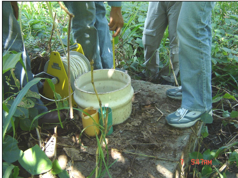
Foto 12. Pozo en tubería de 12" en PVC
