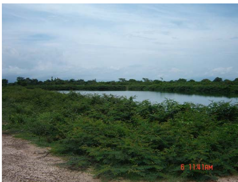
Foto 75. Lagunas de Tratamientos de agua de Chiriguana Vertimiento final a la ciénaga circundante
