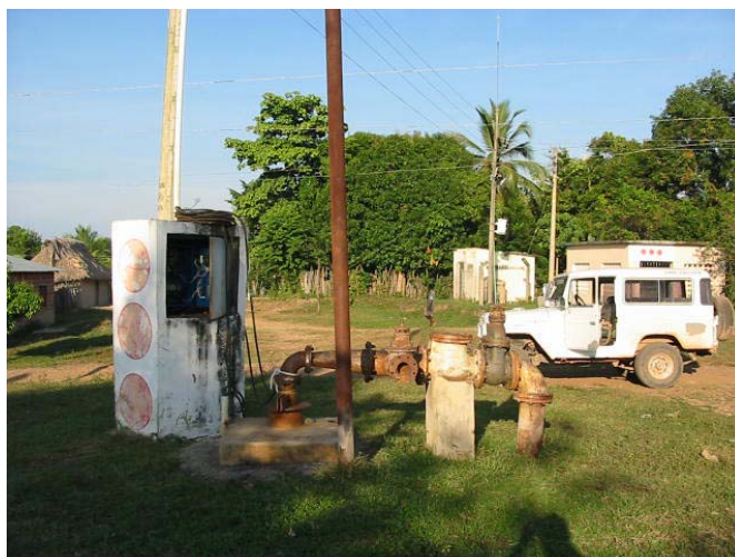
Foto 41. Pozo ubicado al interior del Casco urbano del Municipio de Chimichagua
