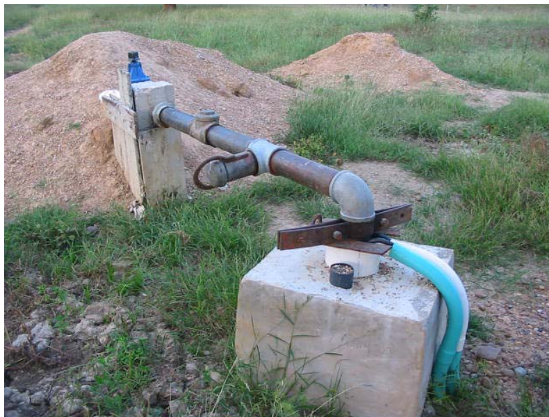
Foto 53. Pozo profundo construido en las afueras del Perímetro corregimiento de Arjona (Astrea)
