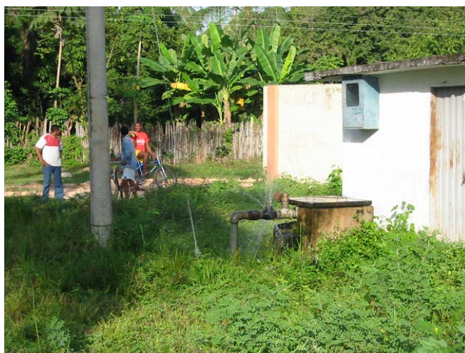
Foto 52. Pozo de abastecimiento de agua del corregimiento Los Palmitos (zona sur)
