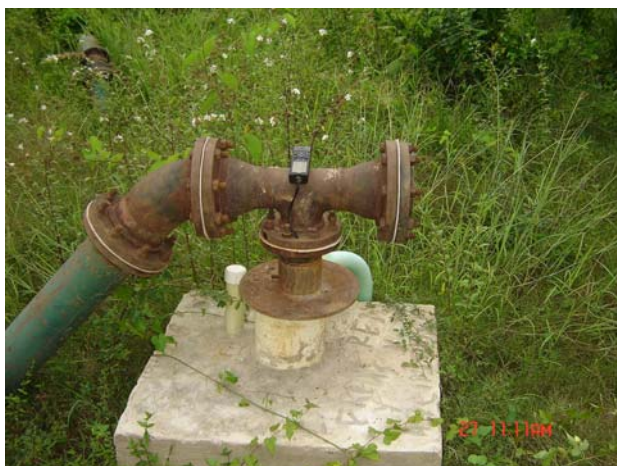
Foto 27. Georreferenciación un pozo profundo de abastecimiento de Chiriguaná.
