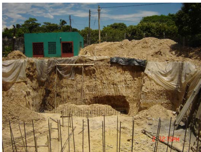
Foto 14. Limos arcillosos amarillos de los Depósitos de Llanura Aluvial (Qlla) aflorantes durante la construcción de la planta de tratamiento de agua de Chiriguaná.
