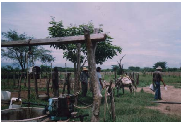
Foto 89. Zona operacional inapropiada de aljibe destapado, equipo de bombeo con residuos aceitosos y combustibles
