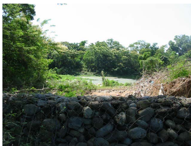
Foto 73. Lagunas de Tratamientos de agua de Becerril.
