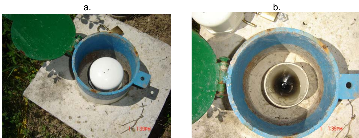
Fotos 97. Diseño final en la cabeza de los piezómetros con sus ademes y capsula metálica para protección de los sensores que se instalaran en los mismos.
