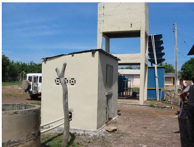
Foto 50. Aljibe y tanque elevado, corregimiento de Boquerón (La Jagua de Ibirico).
