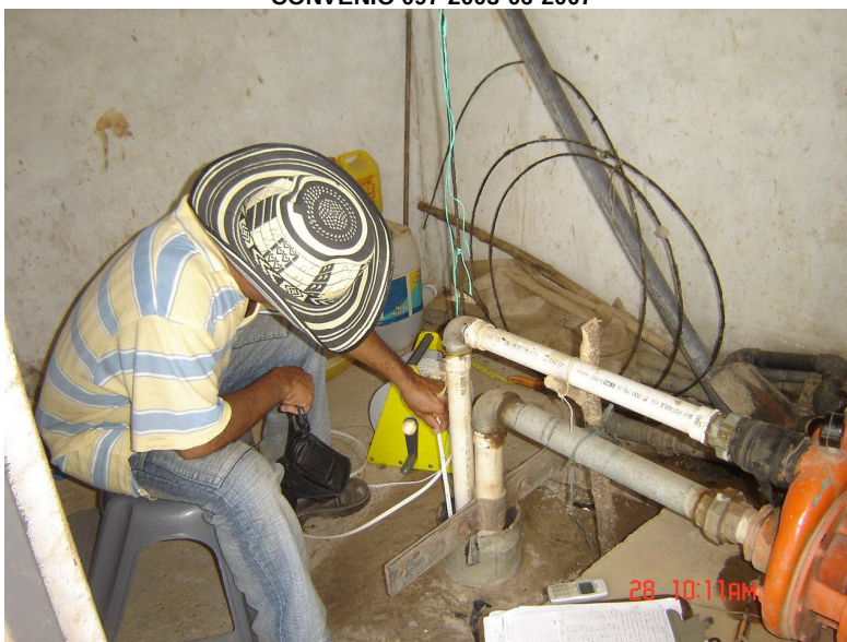
Foto 58. Medición del nivel estático en un pozo, mediante sonda convencional.
