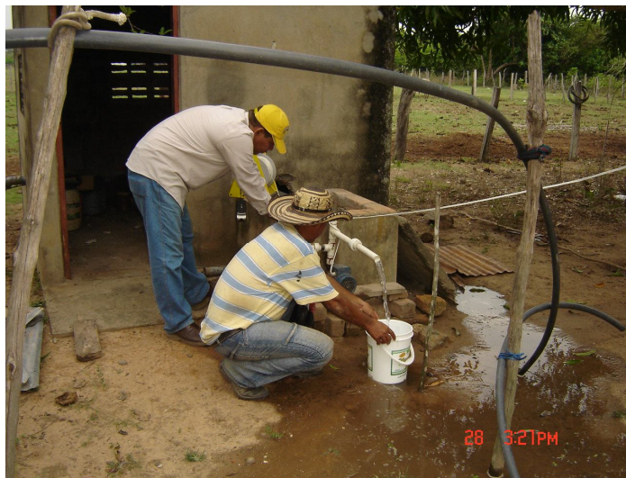
Foto 56. Aforo volumétrico de un pozo de bajo caudal.
