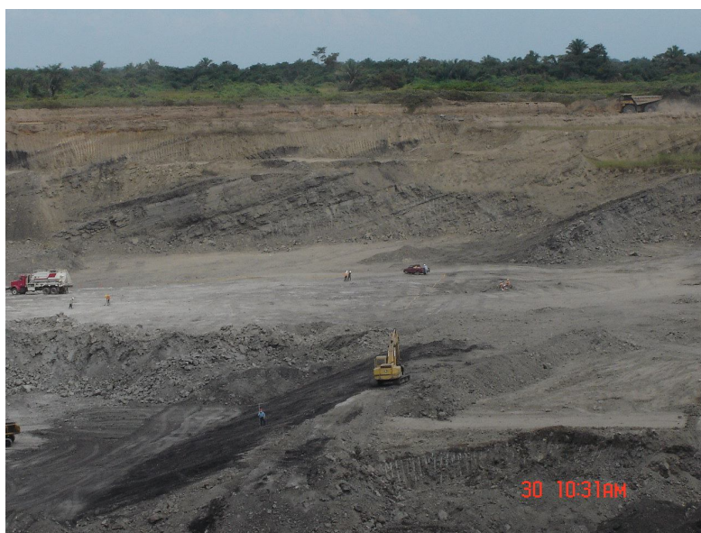
Foto 15. Mantos de carbón inclinados infrayaciendo capas de limos y arenas de los Depósitos de Llanura Aluvial (Qlla), en un pit a cielo abierto de la compañía Prodeco.
