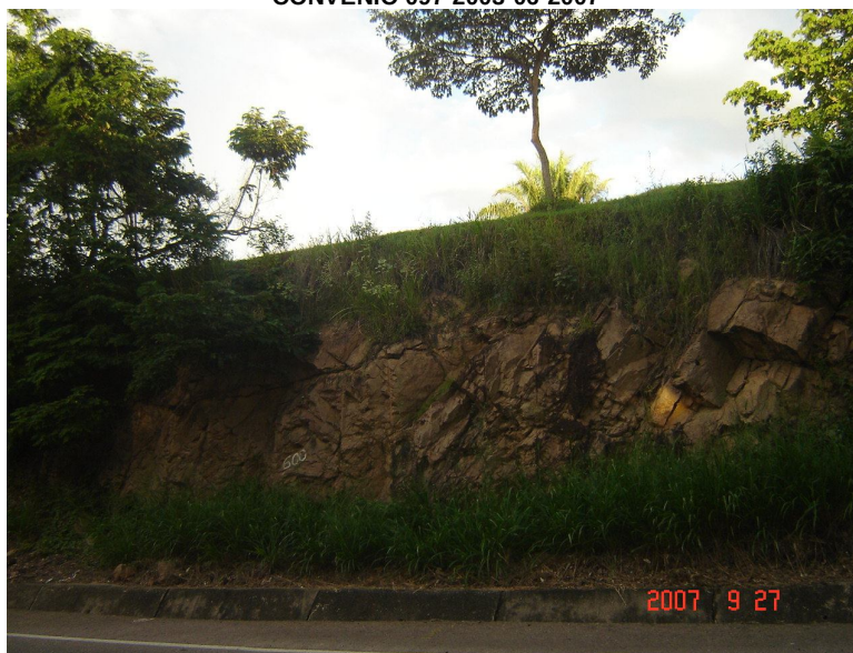
Foto 20. Afloramiento de rocas volcánicas masivas y fracturadas de la unidad (Jqv)
