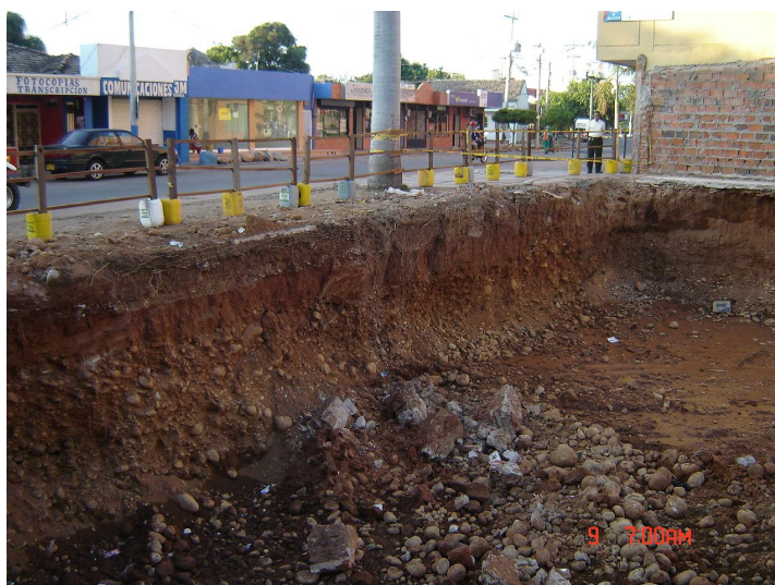
Foto 32. Capas de arenas muy gruesas a gravas en una matriz arenosa durante la construcción del Hotel Tatiban en Valledupar.
