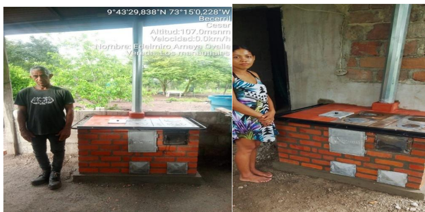
Imagen 18: Construcción de Estufas del proyecto
