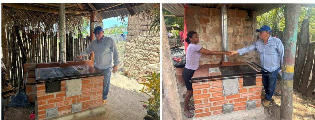
Imagen 19: Construcción de estufas del proyecto
